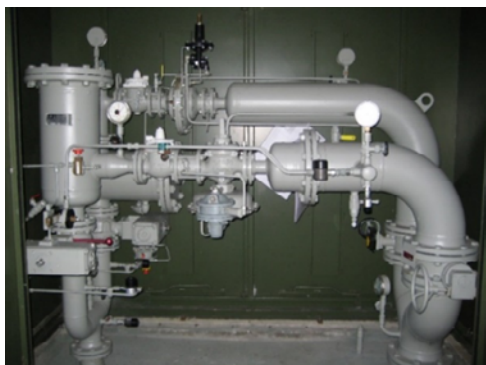
DRS B. de Langestraat Veere: Regelstraat op de voorgrond uitgevoerd met meetpunt < 2D
